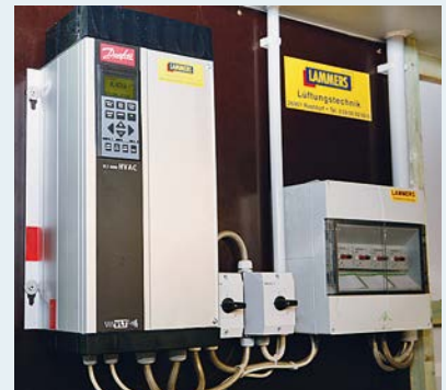
Die Oberschwingungen von Frequenzumrichtern (FU) bewirken eine thermische (Über-)Belastung der Generatorwicklung.
