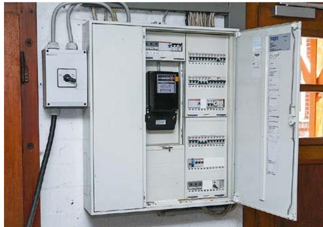
Mit der Überlast durch C-Automaten in der Hausverteilung können Kraftwerksgeneratoren umgehen – die in der Landwirtschaft üblichen Notstromgeneratoren aber nicht.
