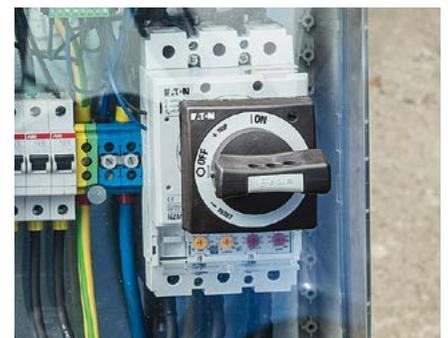
Der herstellereitig einstellbare Generator-Leistungsschalter unterscheidet zwischen einem Kurzschluss und einer beim Anlauf großer Motoren auftretenden Überlast.
