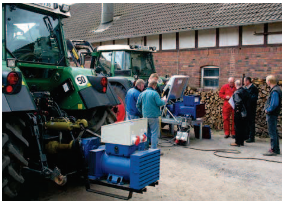
Versuchsweiser Betrieb mehrerer Zapfwellengeneratoren mit Überprüfung der Schutzmaßnahmen
